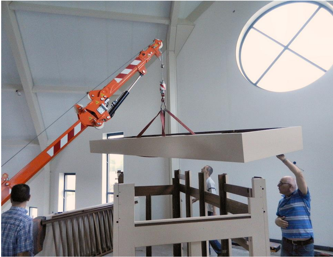
Figuur 42 het frame wordt gemonteerd
