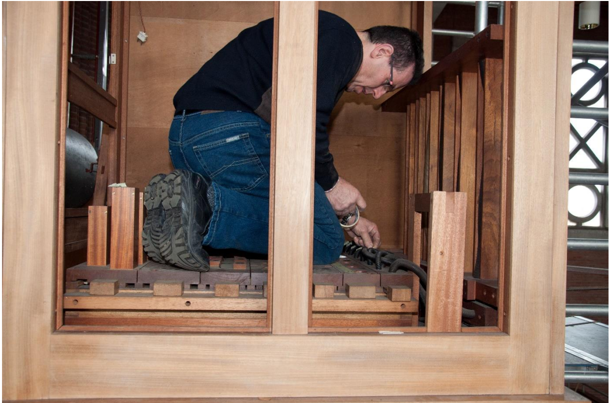
Figuur 20 de slangen worden gemerkt
